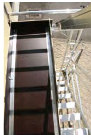
Amplia plataforma de trabajo intermedia con rodapié de seguridad
